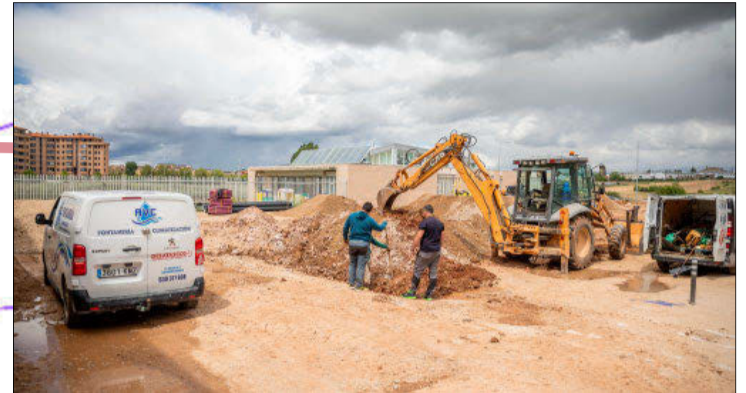
NUEVA PISTA EN SANTA BÁRBARA. Un recinto de habilidad para bicicletas y otros elementos, como patinetes o patines. Es lo que define la pista de 'pump track' que se está acondicionando en la calle Cabildo de los Heros, al lado de la guardería municipal. Unos 750 metros cuadrados de pista en una parcela que se completará con un ajardinamiento y luces.
